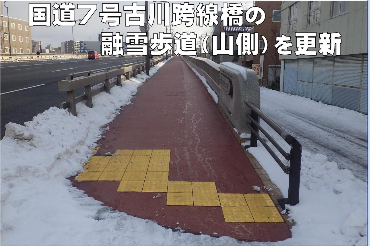
国道7号古川跨線橋の歩道部については、老朽化による故障により、融雪されない状況のため人力により除雪しておりましたが、上り側歩道(山側)を融雪歩道とする舗装として更新し、**12月27日(金) 10時より通行**できるようになりました。
