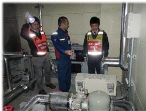
▲ 受水槽の稼動状況確認
