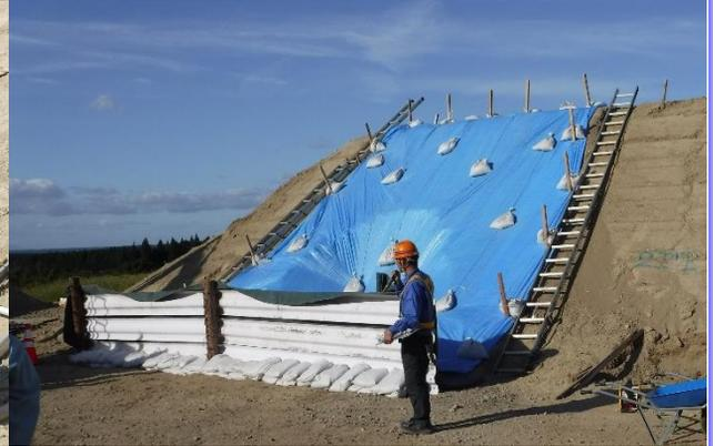
▲建設会社による「大型土のう積み工」「板柵工」「シート養生」作業状況▲
