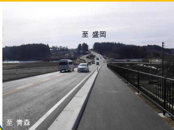
平成24年度に通学路における緊急合同点検結果を受け、平成25年度から国道4号十和田市洞内地区において、衝突事故等の交通事故対策として歩道拡幅および付加車線(右折レーン)整備事業を進めて参りましたが、この度、洞内橋の架け替えも含め国道本線の工事が完成したため、迂回路から本線への交通切り替えを行いました。
