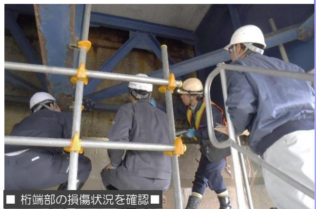
■ 近接目視による点検の様子（床版） ■
