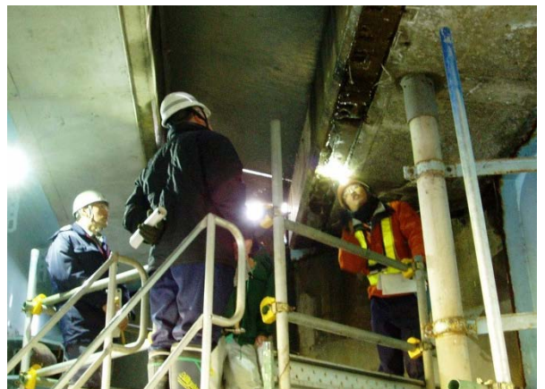
▲近接目視による点検の様子▲
