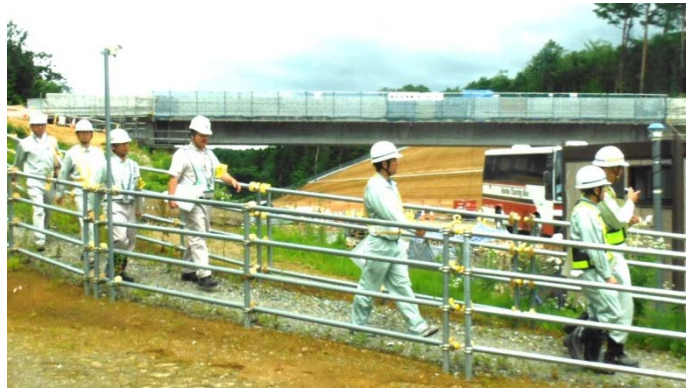
▲現場点検(八戸地区)の様子▲
