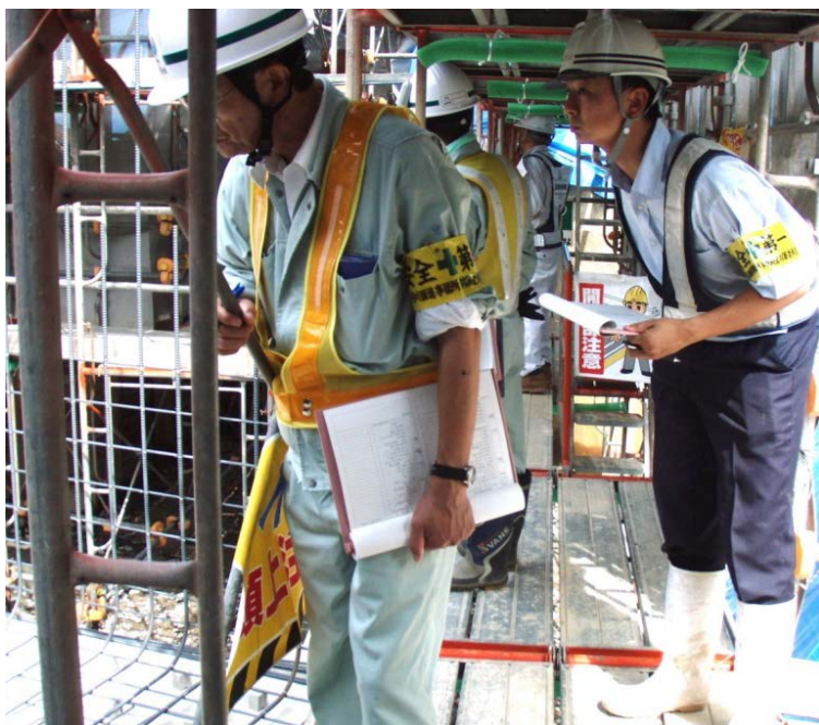
▲現場点検(弘前地区)の様子▲
