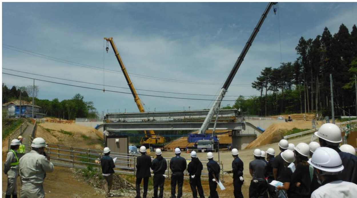
▲▲▲(仮)下天摩こ道橋」上部工工事の見学の様子▲▲▲
