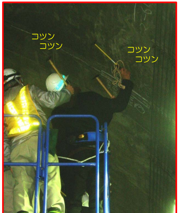
ハンマーを使用した打音点検行っています
