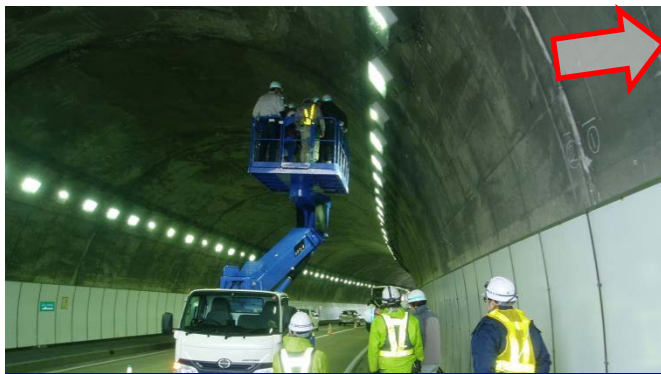
鶴ヶ花トンネルの点検の様子
