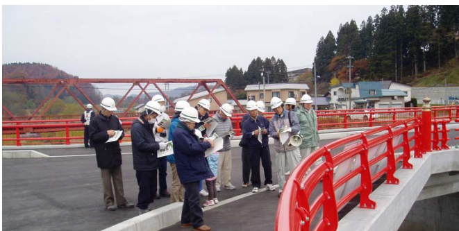
事業中の不動橋(写真奥が架替えするトラス橋)
