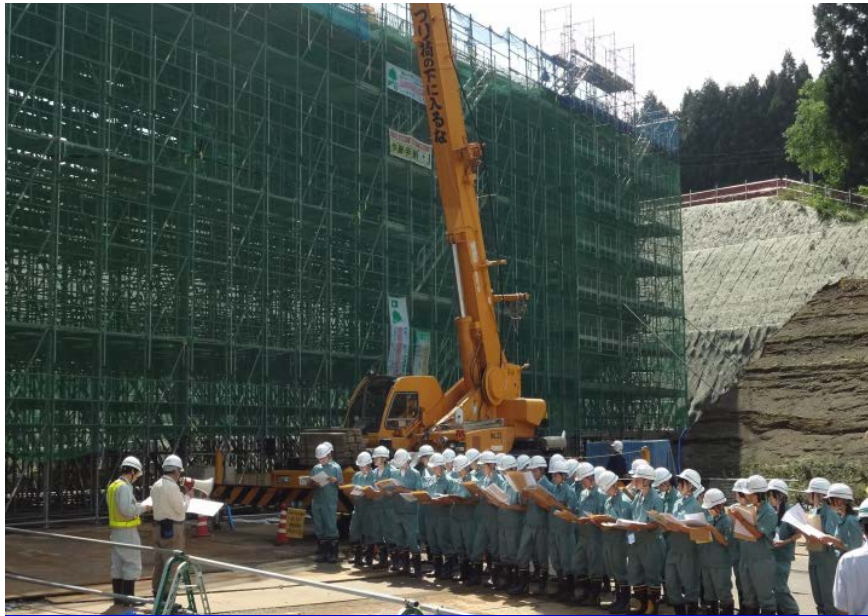
東道ノ上こ道橋上部工工事の見学の様子
