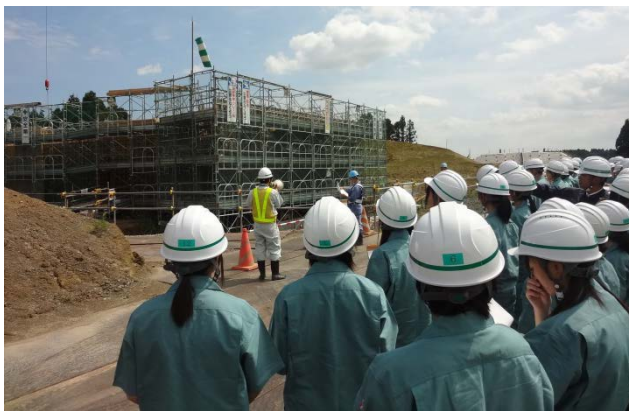
外久根北地区の函渠工工事の見学の様子
