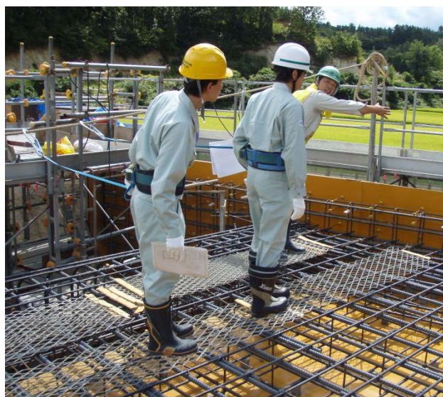
鱒ヶ沢道路の工事現場見学の様子
