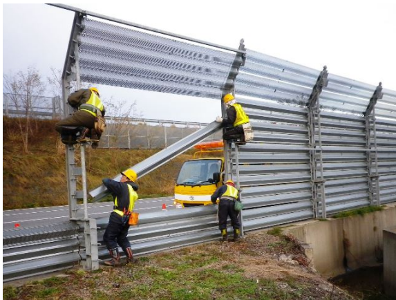
▲夏場たたんでおいた防雪柵を設置
