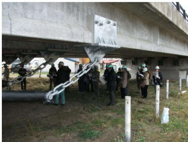
空港浪岡大橋では耐震補強工事の状況について見学していただきました。手前の大きな鎖は、落橋防止装置です。大きな地震の時でも橋が落ちるのを防ぎます。
