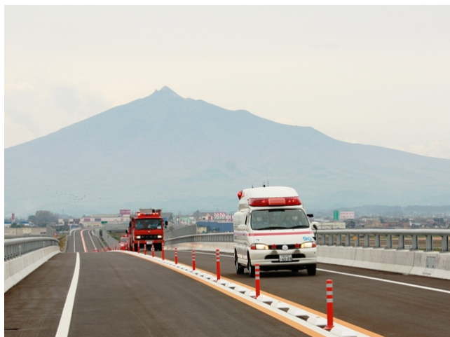
開通前の「五所川原西バイパス」を走行する緊急車両
