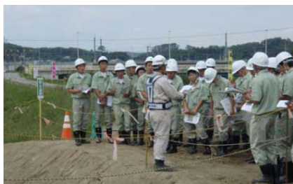
盛土・締め固めの現場近くで説明を受けている様子
