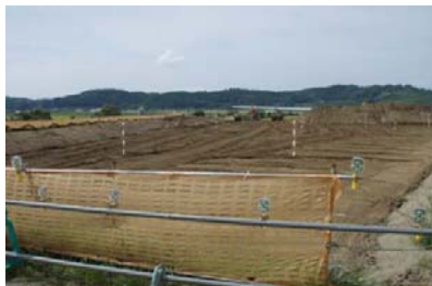
現在、工事現場は盛土・締め固めの最中です
