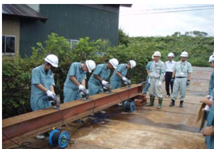
高力ボルトの締め付けの実体験
