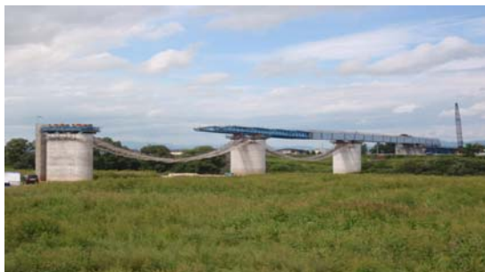
岩木川橋の架設状況。
