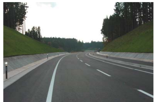
開通した七戸バイパス
