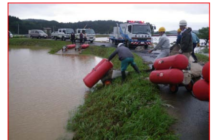
平成23年6月洪水 子吉川での排水ポンプ車による排水作業
