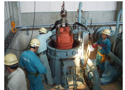
排水機場におけるポンプ原動機等の定期的な点検
