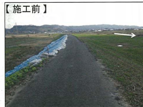
【 施工前 】 川裏法面被災状況 (ブルーシートによる応急措置状況)
