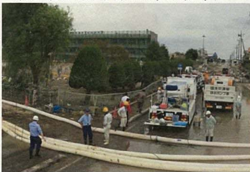
■常総市大生小学校周辺での 緊急排水活動(茨城県常総市)
