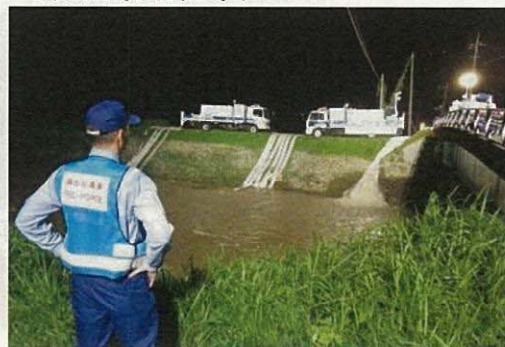
■24時間体制による緊急排水活動 (茨城県常総市)
