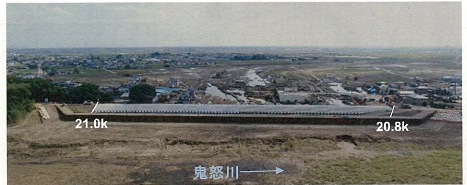
応急復旧完了後の状況(9/27)
