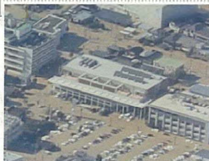
常総市役所の浸水の状況
