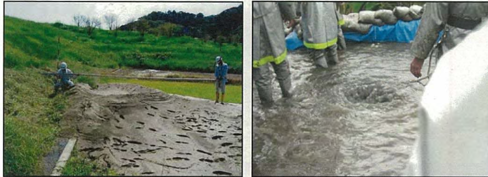
洪水時の堤防等の漏水
