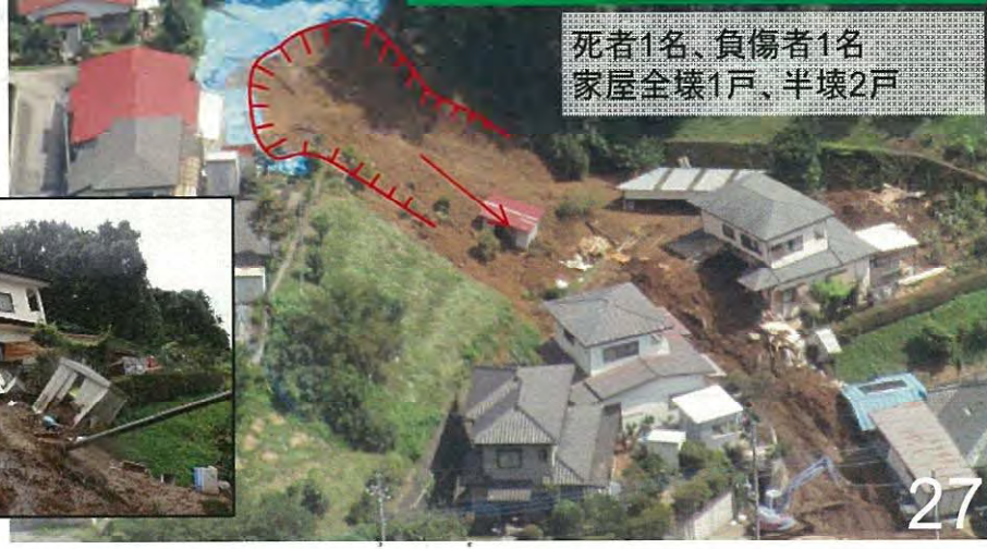
がけ崩れ 栃木県鹿沼市日吉町
