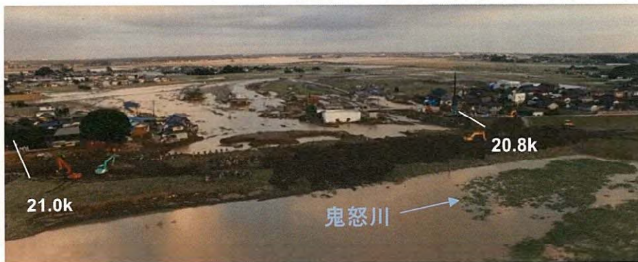
応急復旧状況(9/12)
