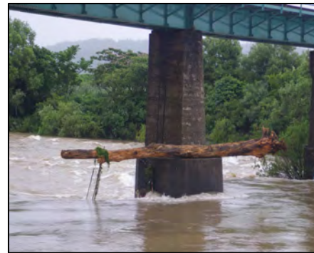
③重要構造物
