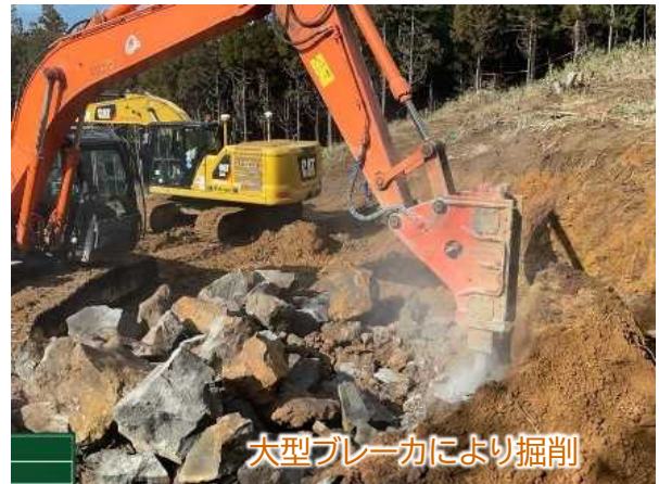
▲中硬岩 掘削状況
