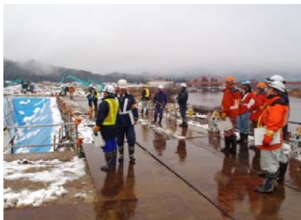
工事現場の点検の様子
