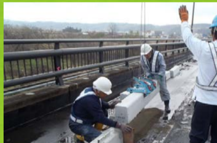
縁石を新しく取替えています
