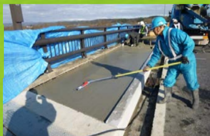
橋の歩道を造りなおしています
