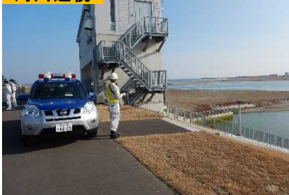
河川巡視の状況
