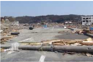
東日本大震災による電柱の倒壊状況
