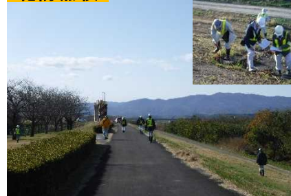
堤防点検の様子
