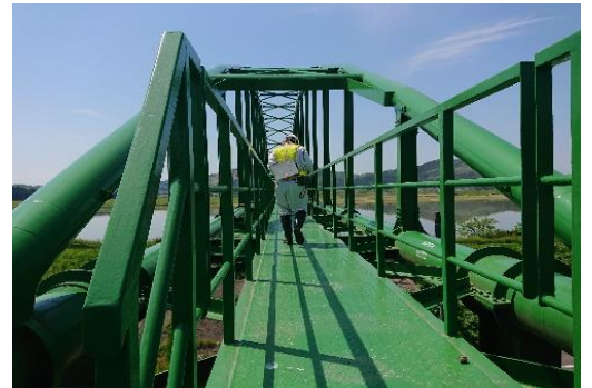
阿武隈川水管橋
