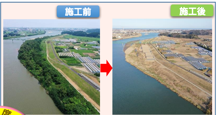
阿武隈川下流岩沼地区河道整備工事
