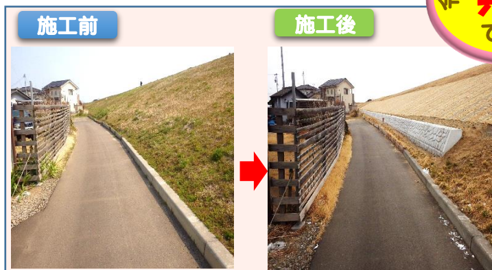
阿武隈川下流岩沼管内外漏水対策工事
