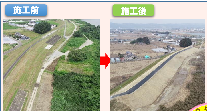
阿武隈川下流右岸亘理地区築堤工事
