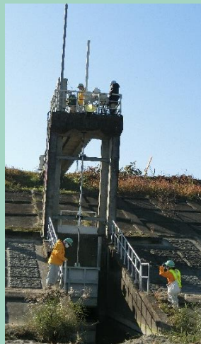
■樋管開閉確認
