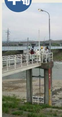
洪水時に本川からの水の逆流を防ぐ施設で、普段施設を操作する操作員と国土交通省職員が、実際にゲートの上げ下げの操作などを行い、確実に止水することの確認や異音など不具合がないか点検をしました。異状箇所は直ちに補修または応急復旧にて対応し洪水に備えています。普段も操作員により、毎月点検が行われています。
