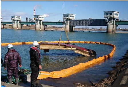
作業状況(車両引き上げ)
