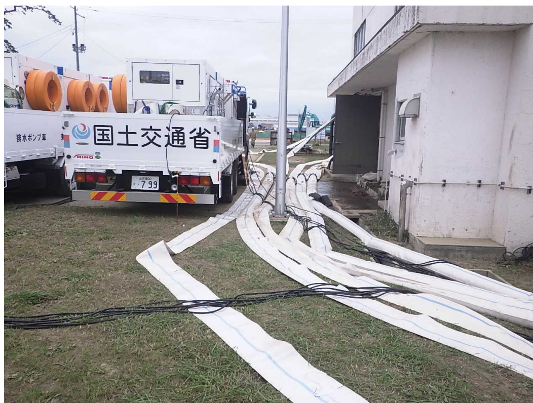
排水ポンプ車活動状況② (場所：宮城県仙台市宮城野区蒲生雨水ポンプ場)
