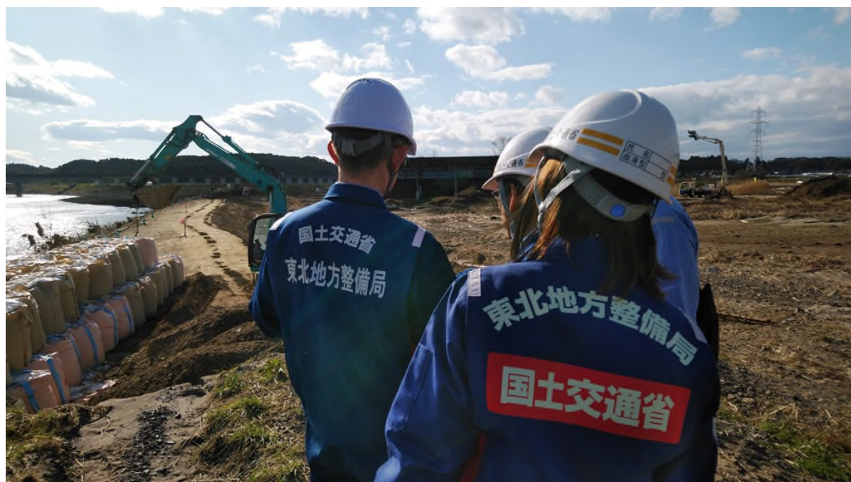
福島県庁リエゾン活動状況② (被災箇所現地調査：福島県西白河郡矢吹町)
