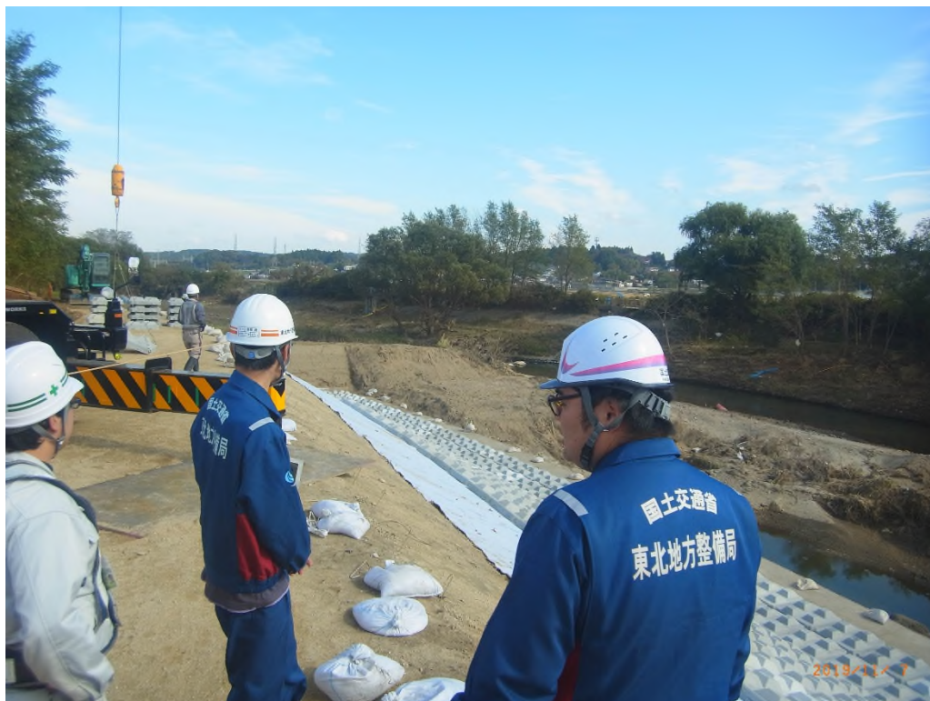
福島県権限代行工事箇所における工事監督状況 (場所：福島県郡山市上行合地先〔阿武隈川水系谷田川〕)
