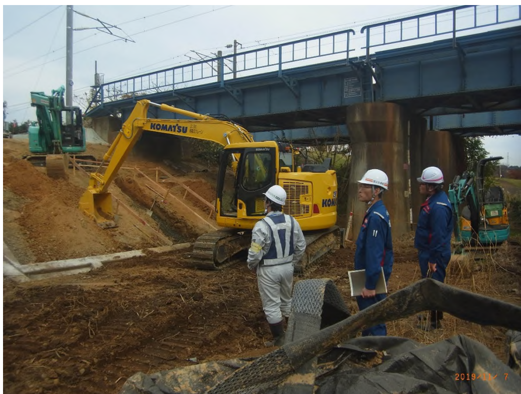
福島県権限代行工事箇所における工事監督状況 (場所：福島県本宮市本宮地先〔阿武隈川水系安達太良川〕)
