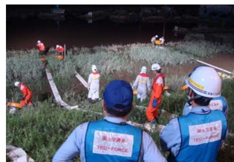
▲ 排水ポンプ車による排水活動
