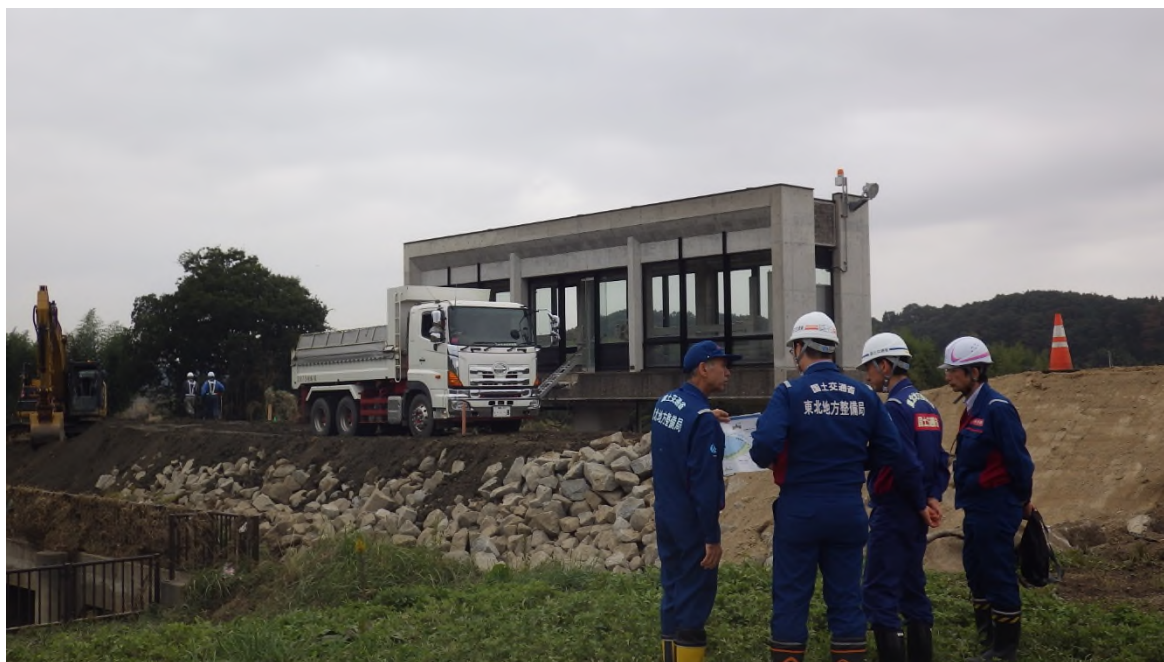
福島河川国道事務所 応援活動状況（施工状況の確認） 場所：福島県須賀川市浜尾地先 阿武隈川堤防決壊箇所
