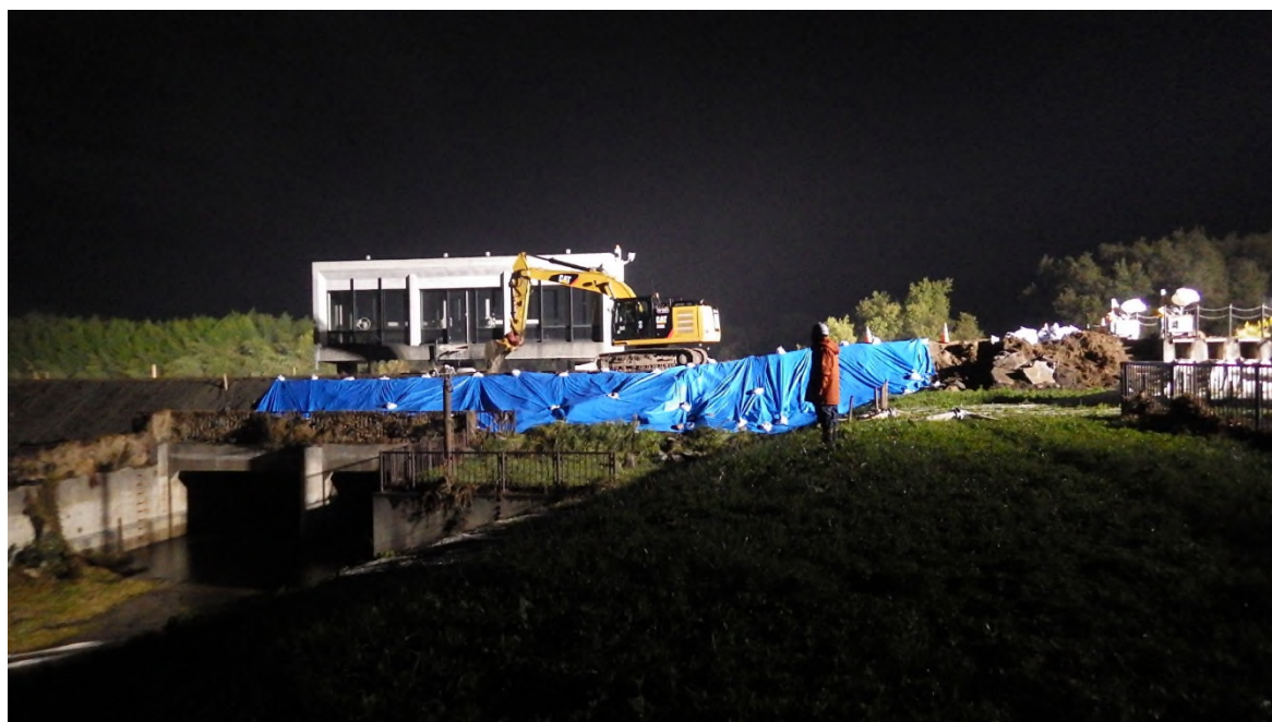
福島河川国道事務所 応援活動状況（24時間施工工事の監督） 場所：福島県須賀川市浜尾地先 阿武隈川堤防決壊箇所
