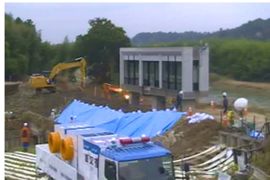
仮堤防盛土完了
