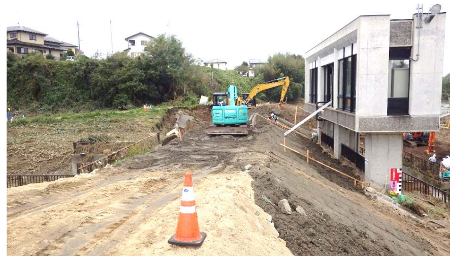
仮堤防盛土施工状況
