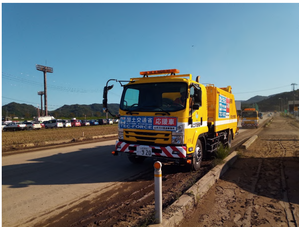
宮城県伊具郡丸森町での路面清掃作業状況
