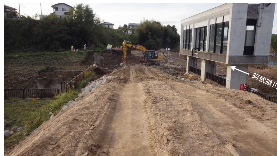
仮堤防盛土施工状況
