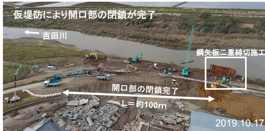
施工状況全景
