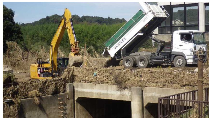
仮堤防盛土施工状況
