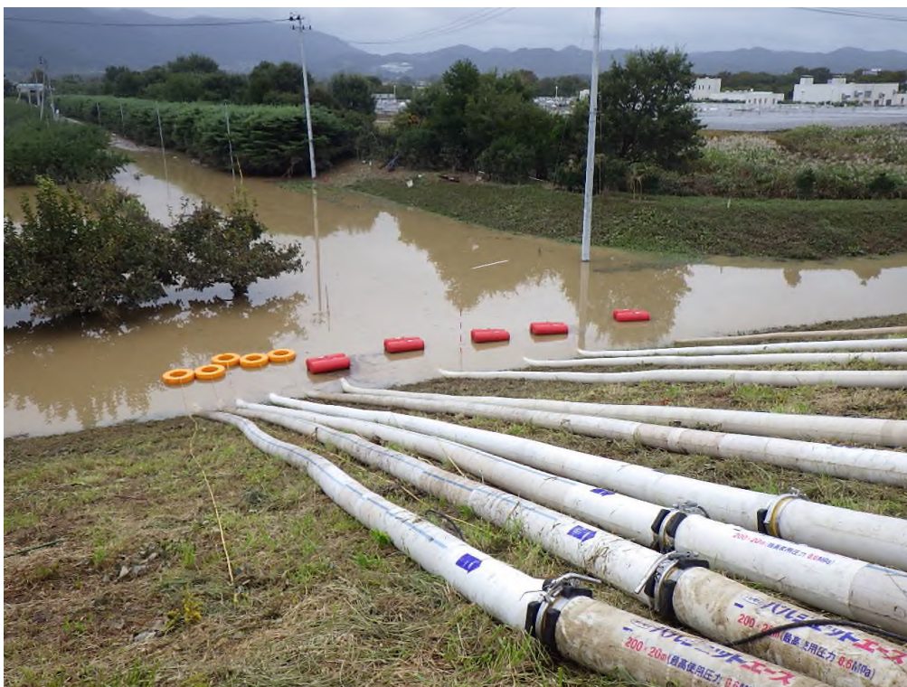
福島県北浄化センター周辺の湛水状況
