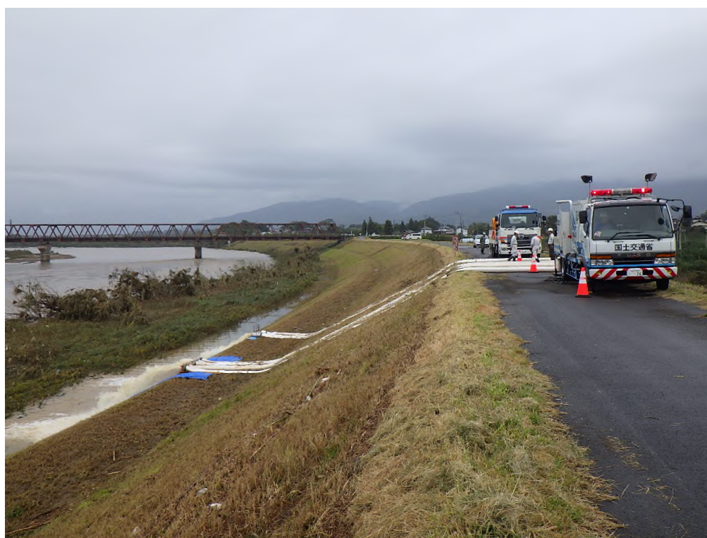
排水ポンプ車による阿武隈川への排水状況
