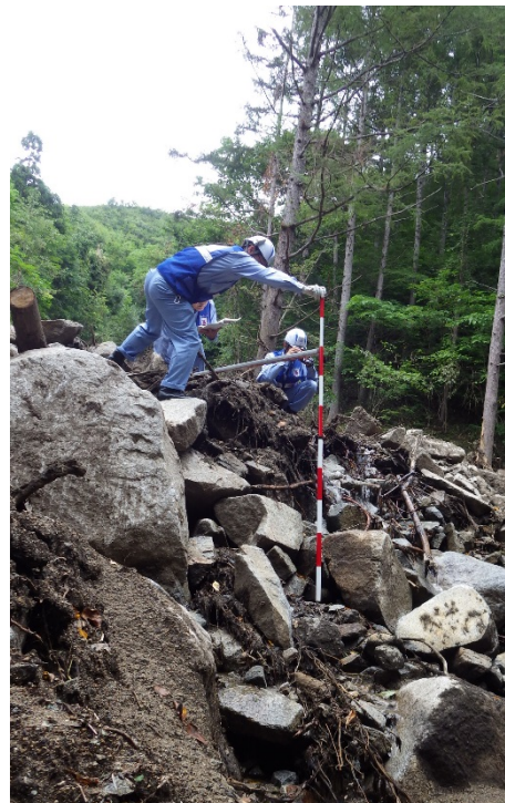
9/12崩落箇所調査状況
