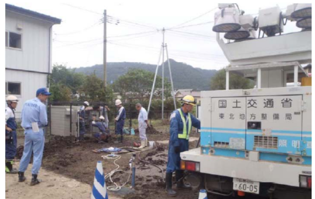
9/2岩泉町小本地区 災害復興住宅へ電源供給
