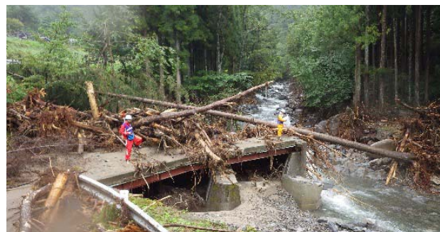
9/13流失した橋の調査状況
