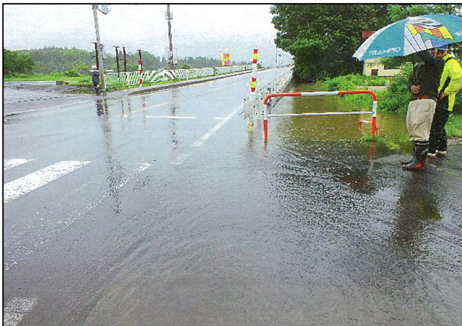
▲国道108号道路冠水状況
