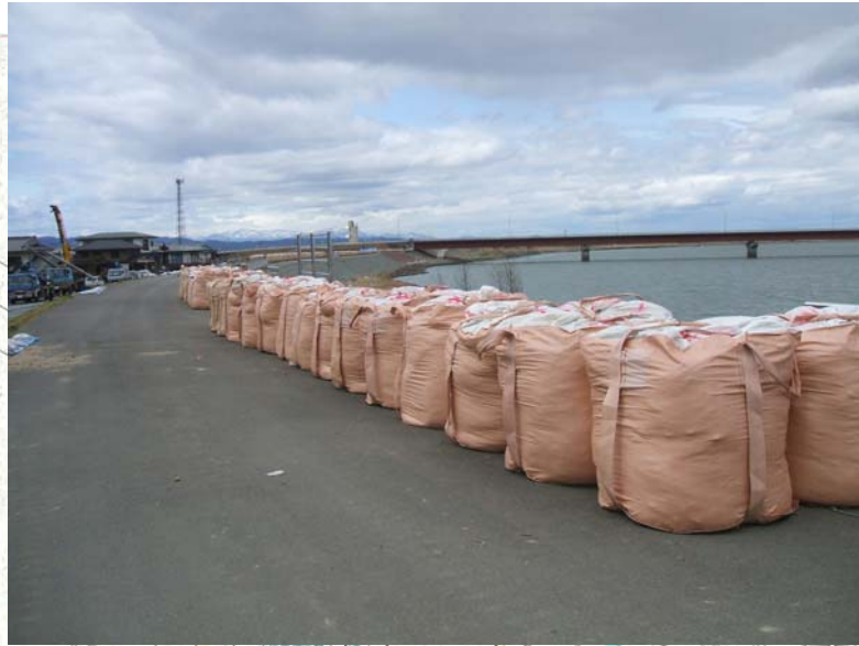
大型土嚢の設置完了
