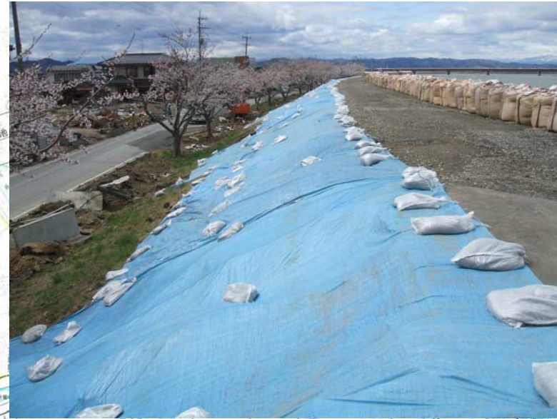
法くずれ部シート張完了
