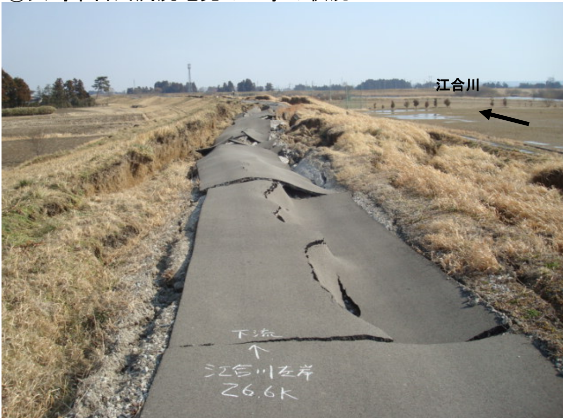
3月11日堤防被災状況 堤防亀裂・沈下
