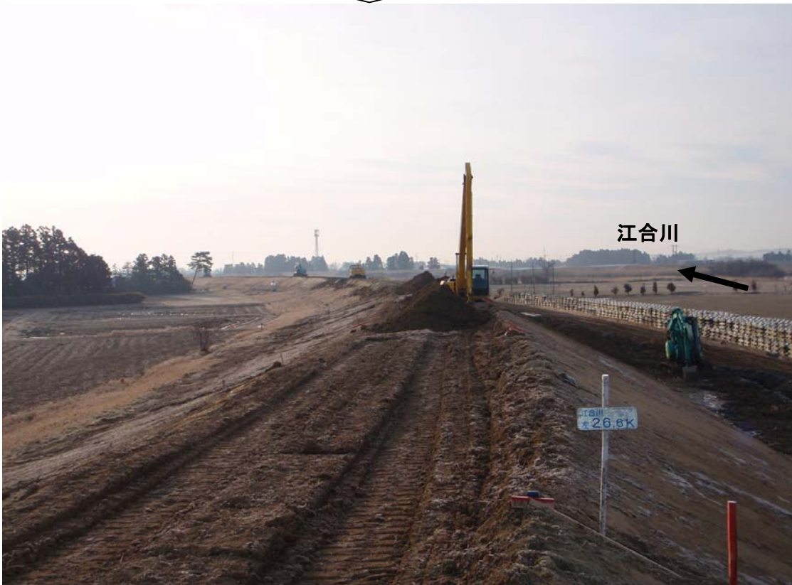
3月24日7時頃 堤防亀裂・沈下の復旧盛土
