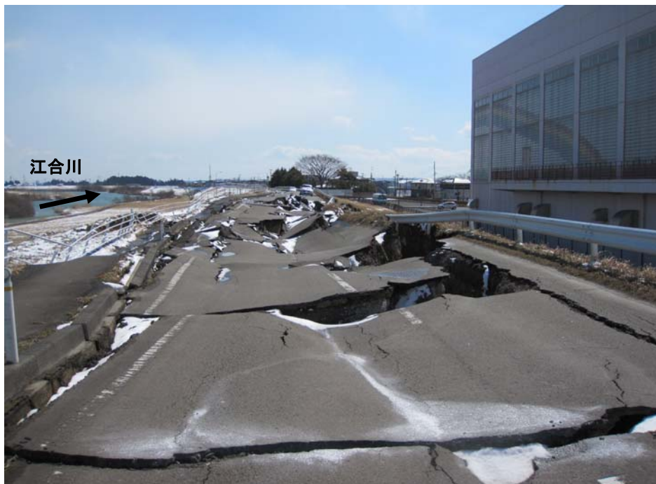
3月17日堤防被災状況 堤防亀裂・沈下
