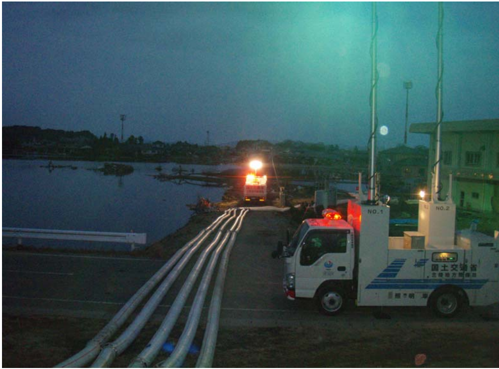
3月22日18時頃 排水ポンプ車による排水の状況
