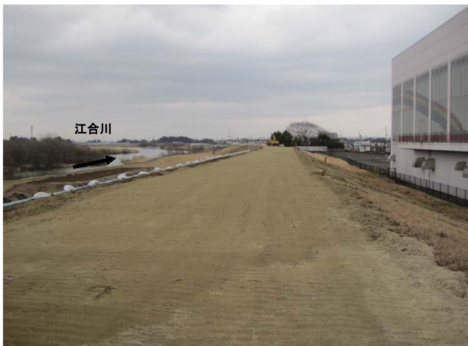
3月22日 復旧盛土完了
