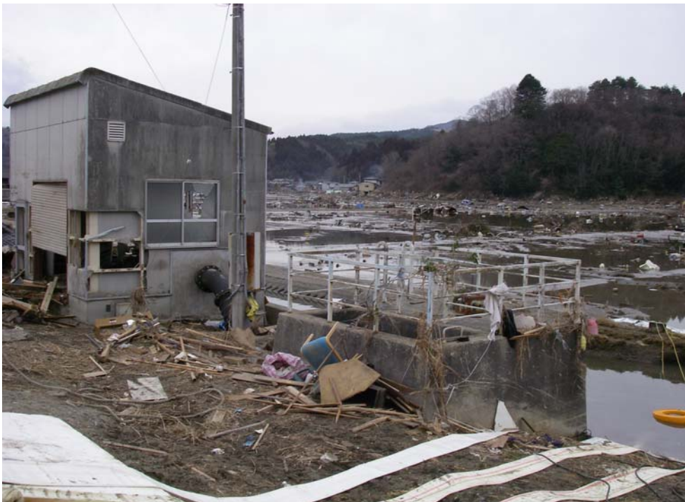
3月21日9時頃 排水ポンプ車による排水後の状況
