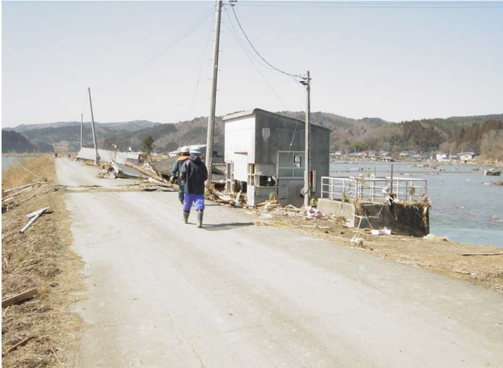
3月19日11時頃の湛水状況
