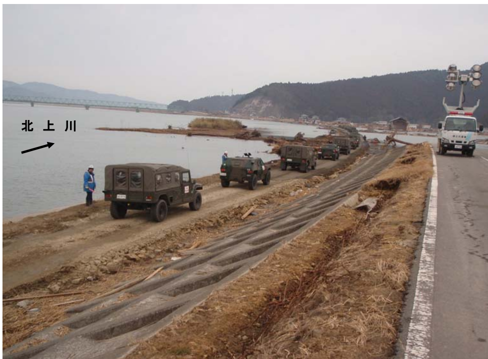
3月21日8時頃 緊急復旧工事により造成した道路を通行する自衛隊車両
