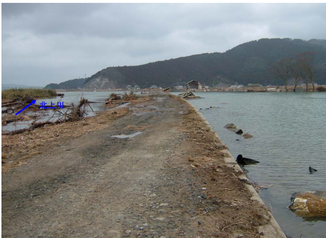
平成23年3月15日 工事用道路設置完了
