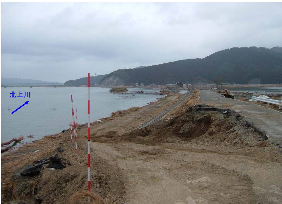
平成23年3月15日 工事用道路設置完了(上流側)
