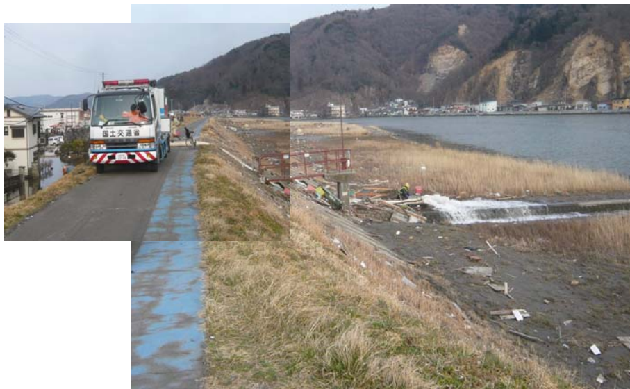
石巻市住吉での排水作業状況(平成23年3月14日)
