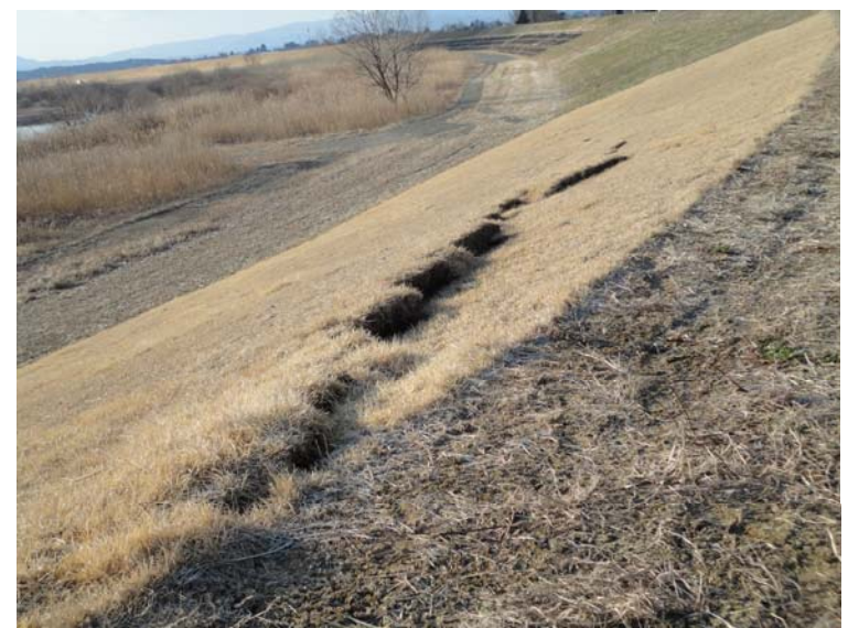
写真④ 堤防法面崩壊 (河口から左岸21.0k付近 角田市江尻地先)
