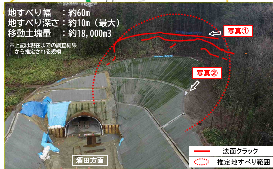
▲(仮称)前波トンネル終点側(酒田側)坑口
